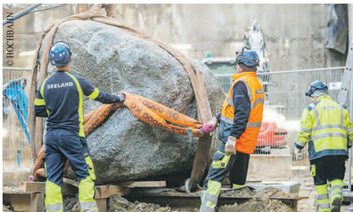
Der rund 22 Tonnen schwere Findling wird vorerst auf der Baustelle zwischengelagert.
